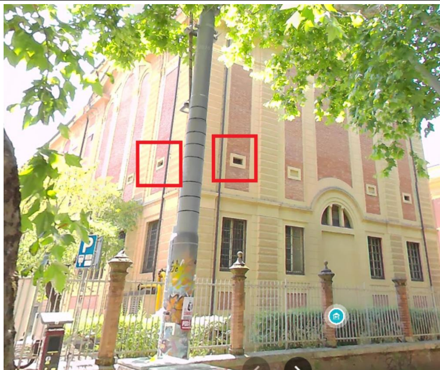
[Foto 7 – Finestre da utilizzare come prese d'aria / espulsione VMC – vista dall'esterno]
